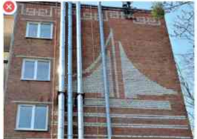
Запрещено перекрытие элементов фасада
